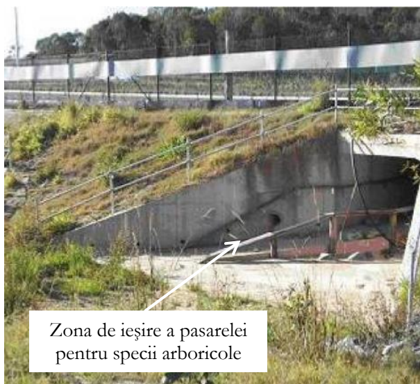
Figura nr. 6-32 Exemple de dotări ale subtraversărilor cu diferite structuri ce pot fi utilizate de diferite specii de faună (Veage & Jones, 2010, Iuell, 2003)
