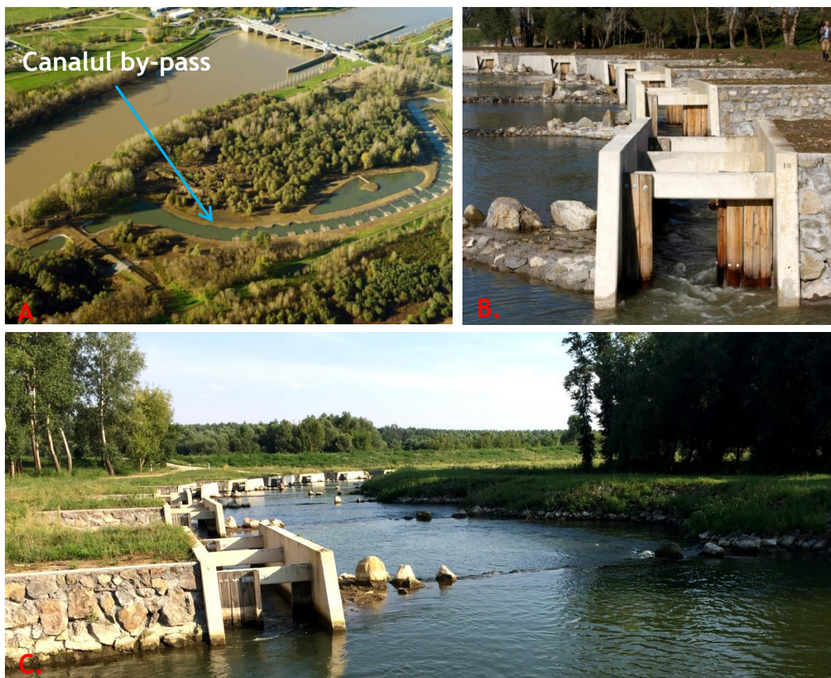
Figura nr. 6-49 A. Canalul by-pass (vedere de ansamblu); B. Scara de pești cu structuri de trecere verticale; C. Vedere de ansamblu a zonei din amonte a scării de pești (sursa: Tünde, 2015)
