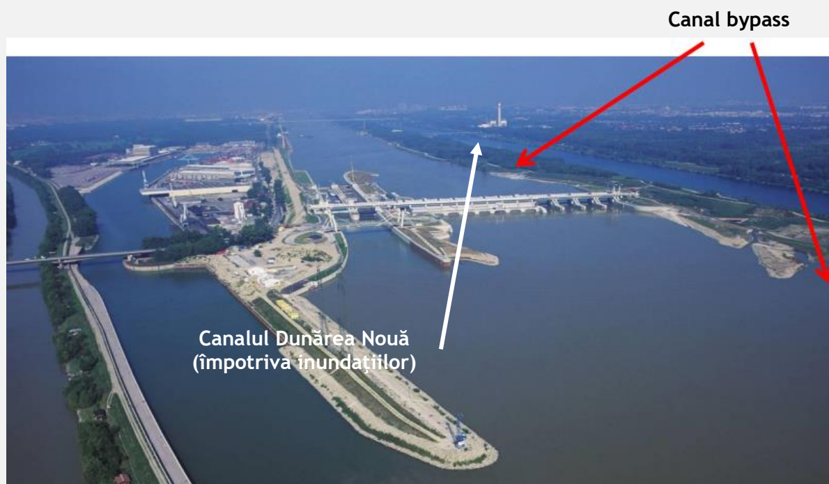
Figura nr. 6-52 Zona hidrocentralei Freudenau, împreună cu canalul Dunărea Nouă și canalul bypass (BOKU, 2015 16 )
