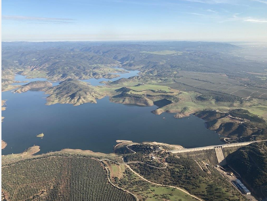
Figura nr. 6-68 Barajul Breña II
