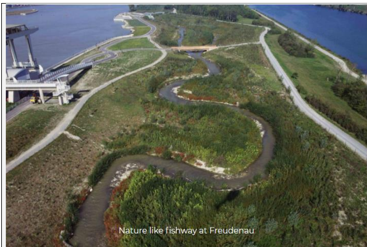
Figura nr. 6-53 Vedere detaliată a canalului bypass de la hidrocentrala Freudenau (FITHydro, 2021 17 )
